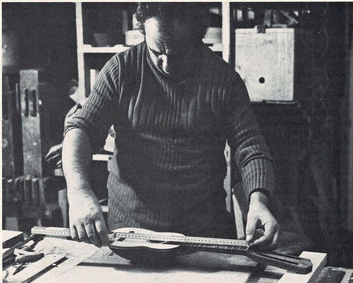
11 Etalonnage avant la mise en place du chevalet.
